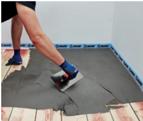
Applicering av Planipatch Xtra Zero + Latex Plus på träunderlag
