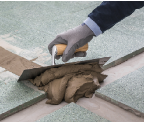
Fylla en kabelkanal med Planipatch Xtra Zero
