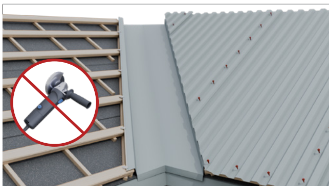
Skär ut vinkeln på plåtarna. Använd INTE vinkelslip.
