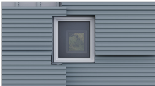
Mät ut öppningsmått för plåten.
