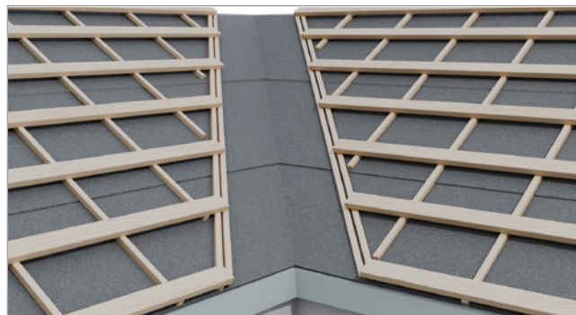
Läkta upp taket för rännalsplåt.
