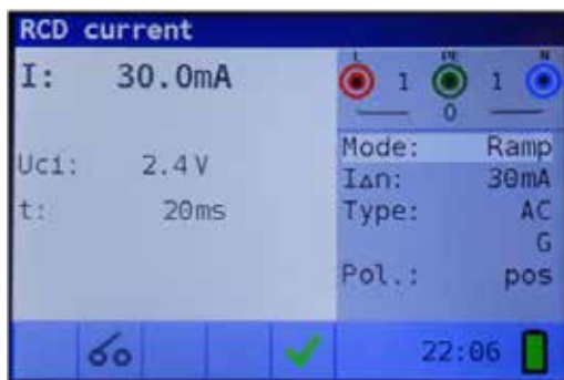
Figur 4 17: Exempel på resultat av utlösningssströmsmätning
